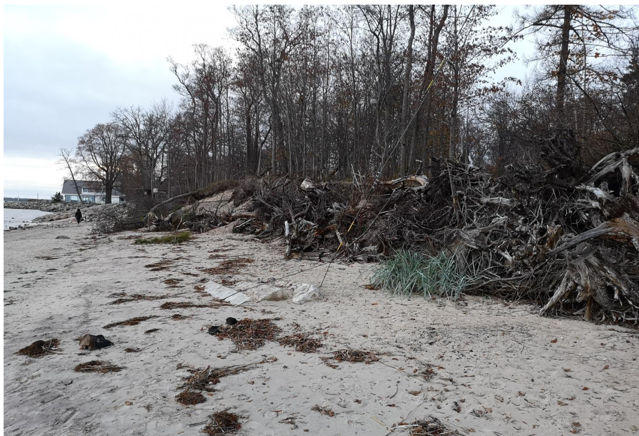
Foto 7. Kohvikust veidi idas on astangu jalami stabiliseerimiseks sinna paigutatud nende puude juurikad, mis varasemate tormidega astangu pervelt alla varisesid.
