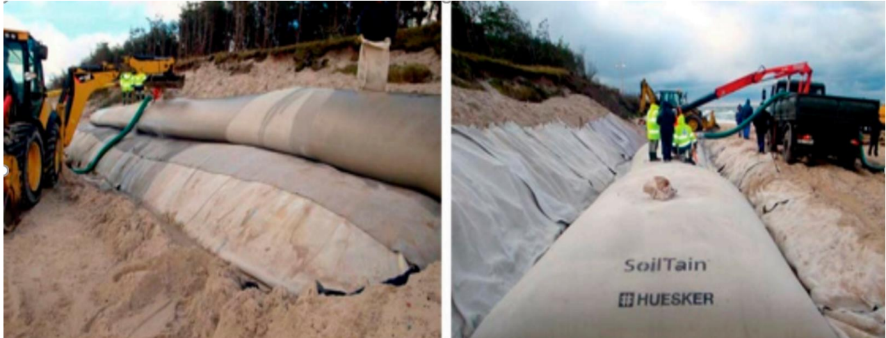
Joonis 3.2. SoilTain@tube ehituse ajal Rowys, https://www.huesker.co.uk .
