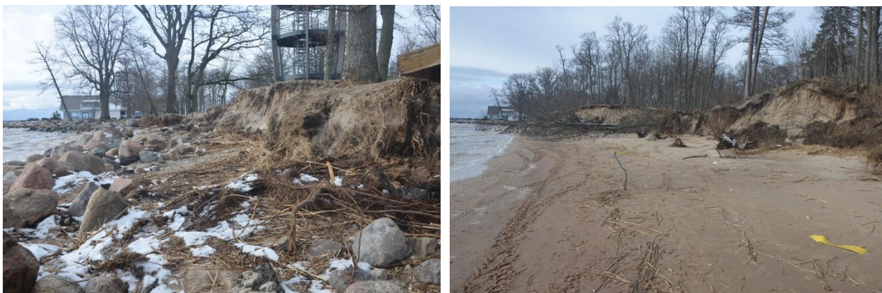
Foto 1.2. 1a (vasak). Vaade purustatud rannakindlustusele ja murrutatud nõlvale. Taamal Doberani kohvik 29.02.2020. 1b (parem). Vaade värsketele murrutusastangule, tüüpiline murrutuse kiirenemine vahetult murrutusastangu lõpus. Kaugemal Doberani kohvik 29.02.2020.
