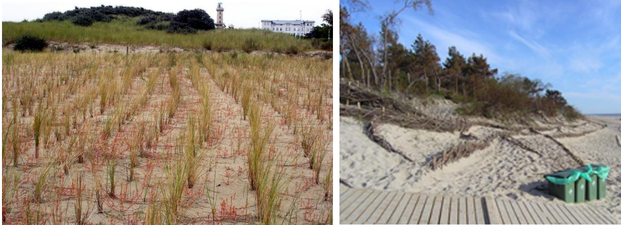
Foto 6. a) luidete kasvatamine Saksamaal, Warnemünde rannas; b) maismaa suunas liikuva liiva kinnistamine punutiste abil Palanga rannas.
