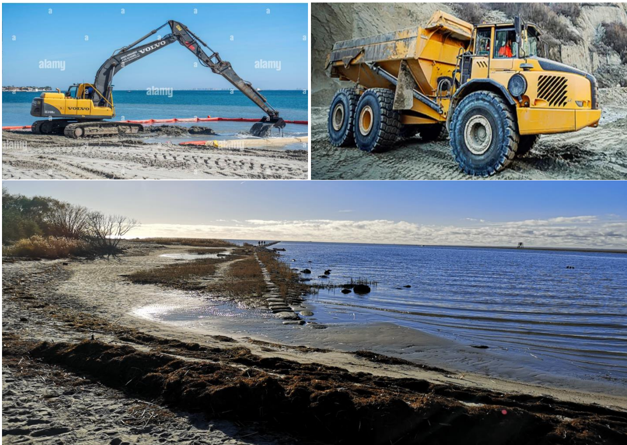
Foto 6.5. a) Pika noolega ekskavaator süvendab; b) dumper tüüpi karjääriveok veab esmase nõrgumise järel materjali suurema tee äärde kogumisplatsile; c) ala, kust pääseb väikese vaevaga dumper tüüpi autoga settekehalt rannale
